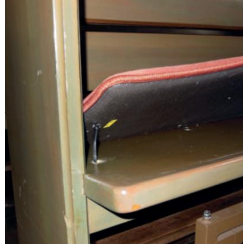
Ev.-luth. St. Johannis Kirche Uslar – Die Wassertemperatur der bestehenden Unterbankheizung wurde stark abgesenkt und zusätzlich elektrische Sitzkissenheizung platziert.
